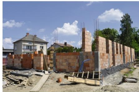
Plac budowy w dniu 23 maja 2017. Fot. Lech Chodacki
